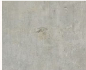
S-03 béton S-03 béton
